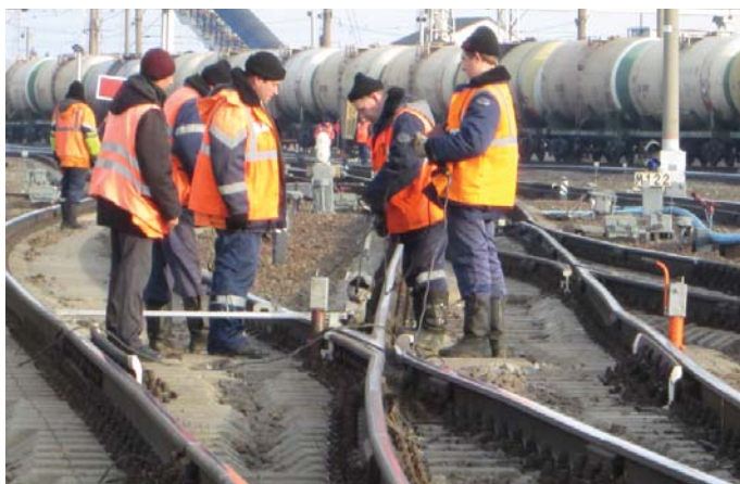
Осмотр состояния рельс и шпал
