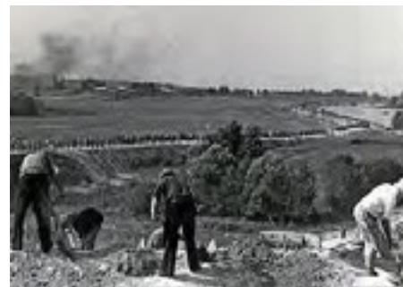
Строительство оборонительных сооружений
